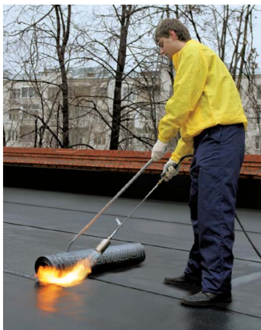
Fot. 8 Montaż papy termozgrzewalnej
