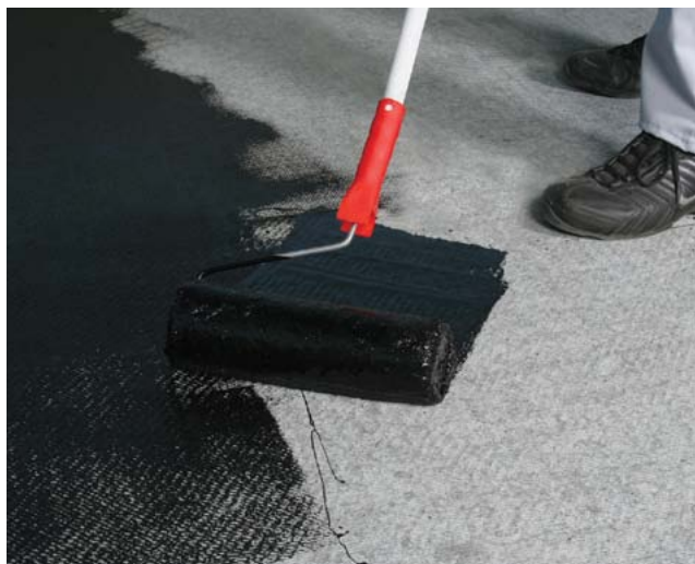
Rys. 2 Gruntowanie podłoża
