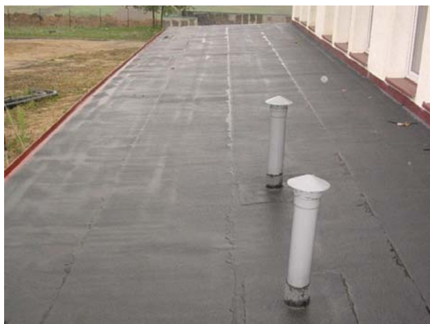
Fot. 27 Przegrzanie materiału podczas zgrzewania
