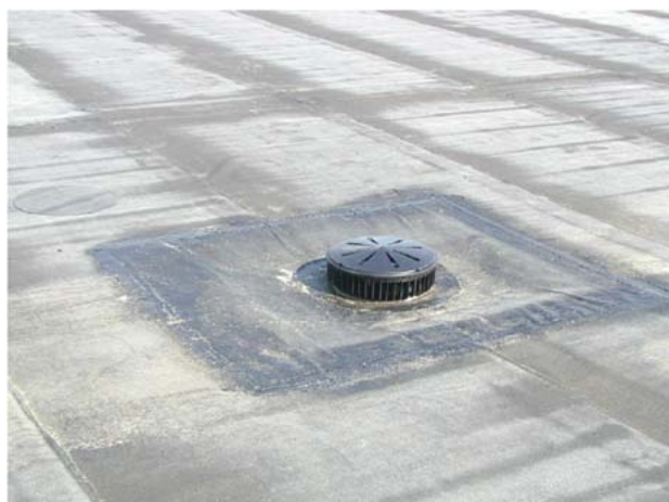
Fot. 17 Wpust dachowy
