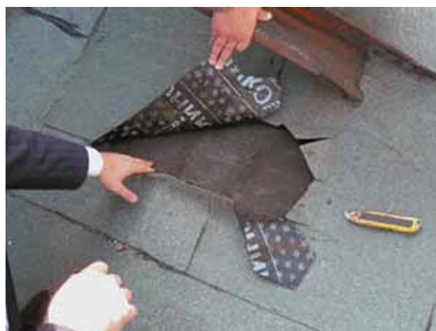
Fot. 26 Niedogrzenie papy podczas zgrzewania
