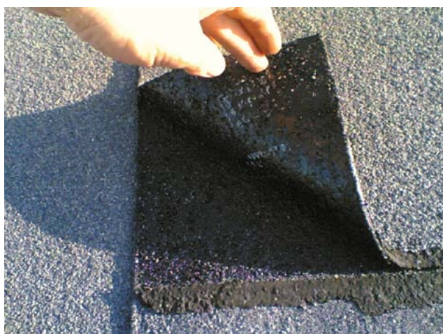
Fot. 26 Niedogrzenie papy podczas zgrzewania
