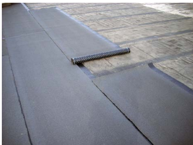
Fot. 22 Zmiana kierunku układania pap
