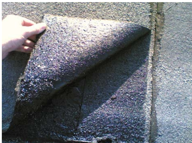
Fot. 25 Efekt nie wtopienia posypki na zakładach poprzecznych
