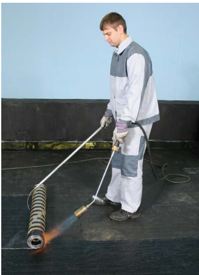
Fot. 14 Układanie papy MIDA REMONT SUPER
