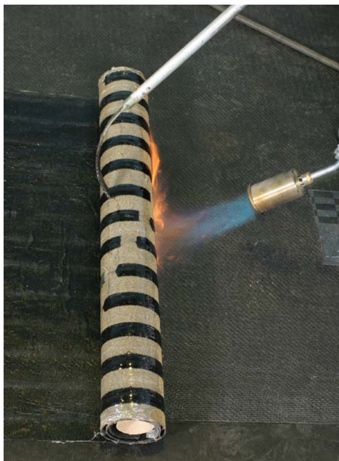
Fot. 14 Układanie papy MIDA REMONT SUPER
