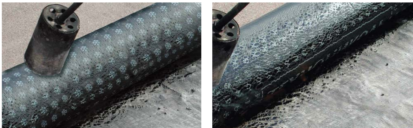
Fot. 9 Topienie grafiki na spodniej warstwie materiału podczas prawidłowego zgrzewania
