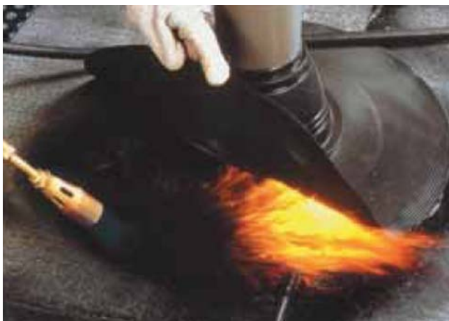
Fot.18 Obróbka rury
